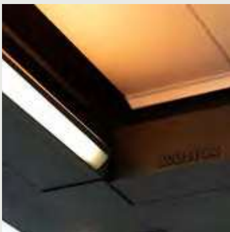
ÉCLAIRAGE LED SUR LA GOUTTIÈRE
